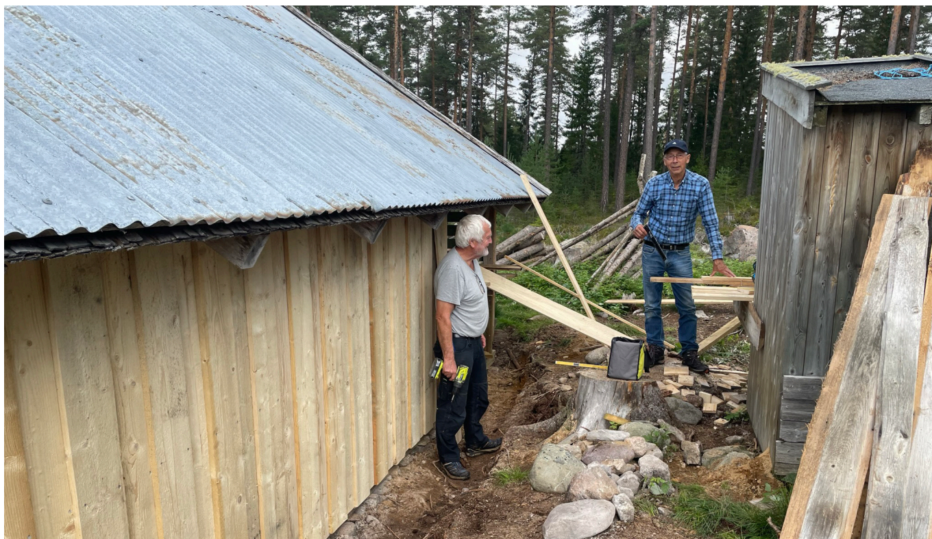
Rolf Kjellmo og Sverre Vidar Engen fra HHT, Løiten krets restaurerer stallen ved Hølmyrkoia. Foto: Jan Johnsrud.
