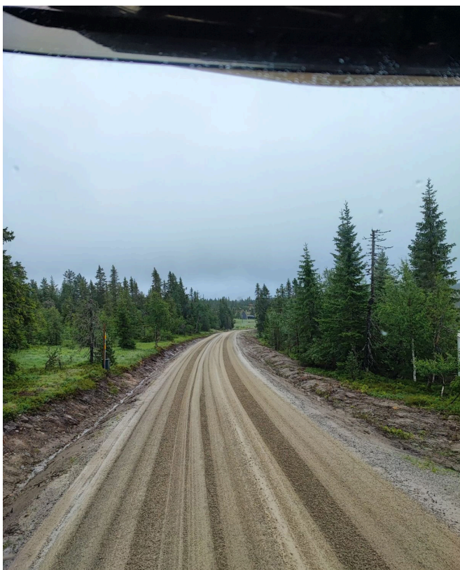
Oppgradering av Svaenlivegen. Foto: Johan Chr. Fischer.
