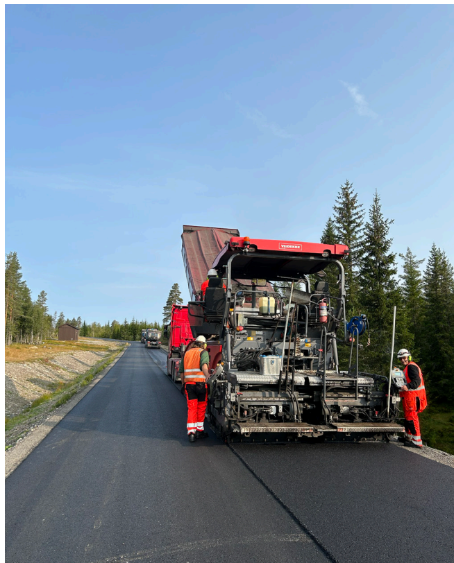
Asfaltering av Budorvegen. Foto: Johan Chr. Fischer.
