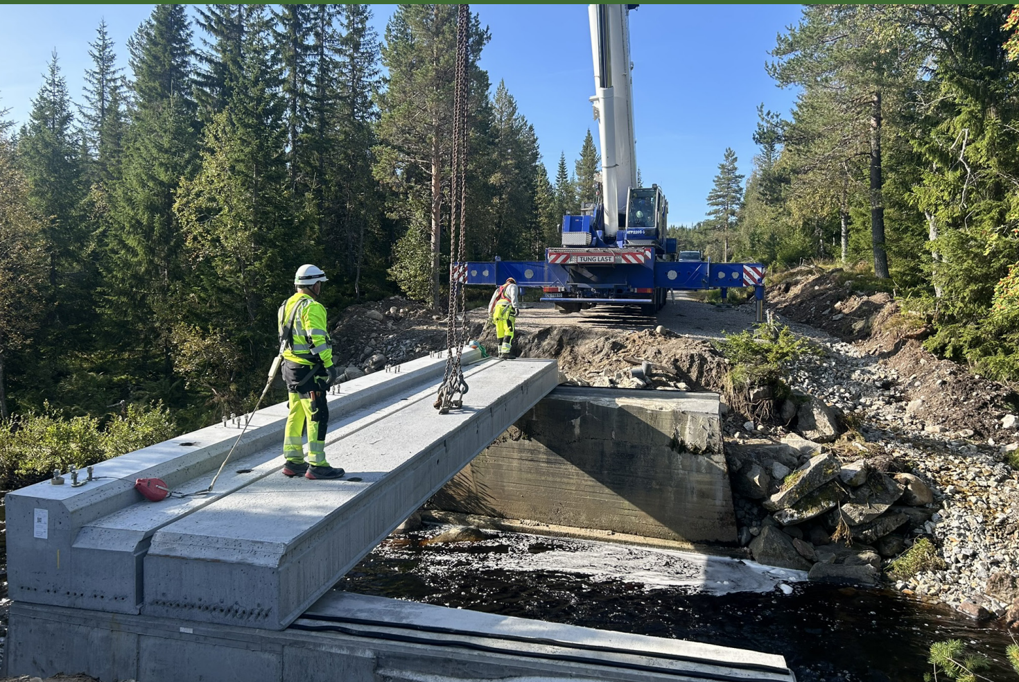
Her bygges det ny bru i veien til Nordhue. Foto: Johan Chr. Fischer
