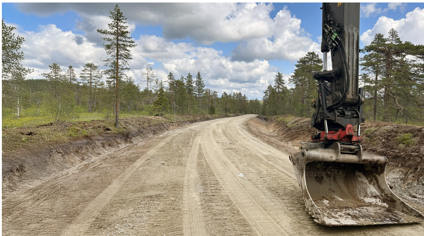
Grøfting av Østre Fjellveg. Foto: Johan Chr. Fischer
