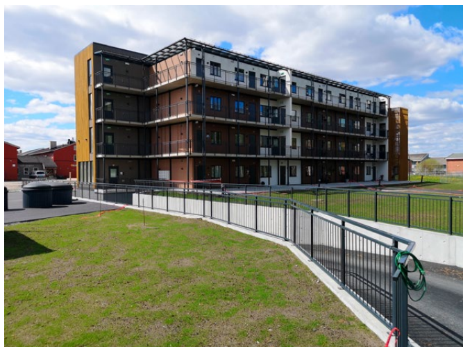
Første byggetrinn Kildetunet ferdig. Foto: Johan Chr. Fischer.
