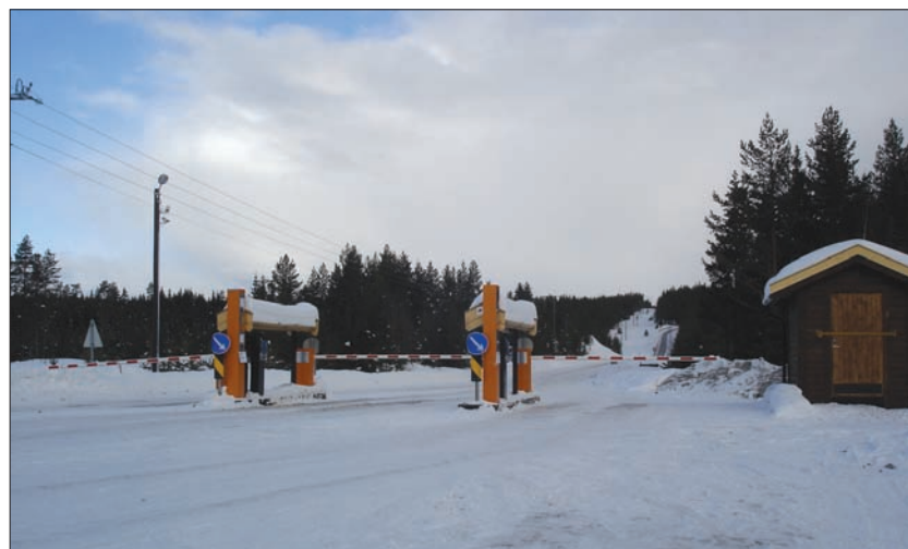
Nytt bomanlegg på Budorvegen. Foto:JCF
