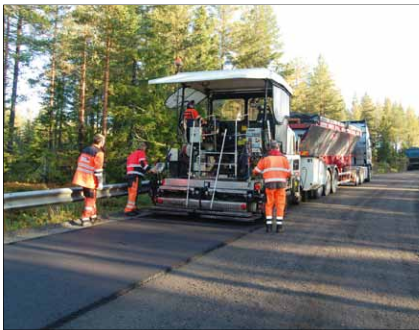
Ny asfalt på Budorveien. Foto: SK.
