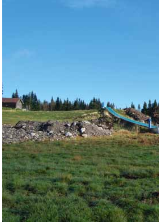
Forbedring av akeanlegg. Foto: JCF.
