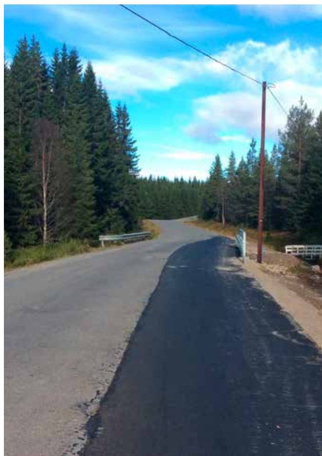
Utvidelse av bru, Budorvegen. Foto: Arve Smestad.
