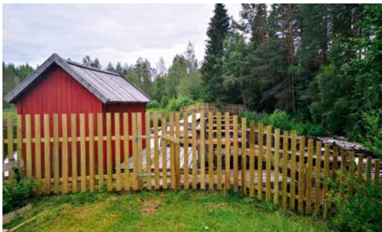
Sikringstiltak i form av gjerdning og skilting er utført ved Hamnardammen. Foto: EJ
