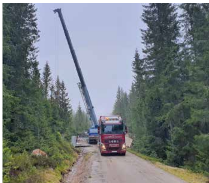
Utskifting av bru i Djupdalsvegen. Foto: Bernt Bjørnsgaard.
