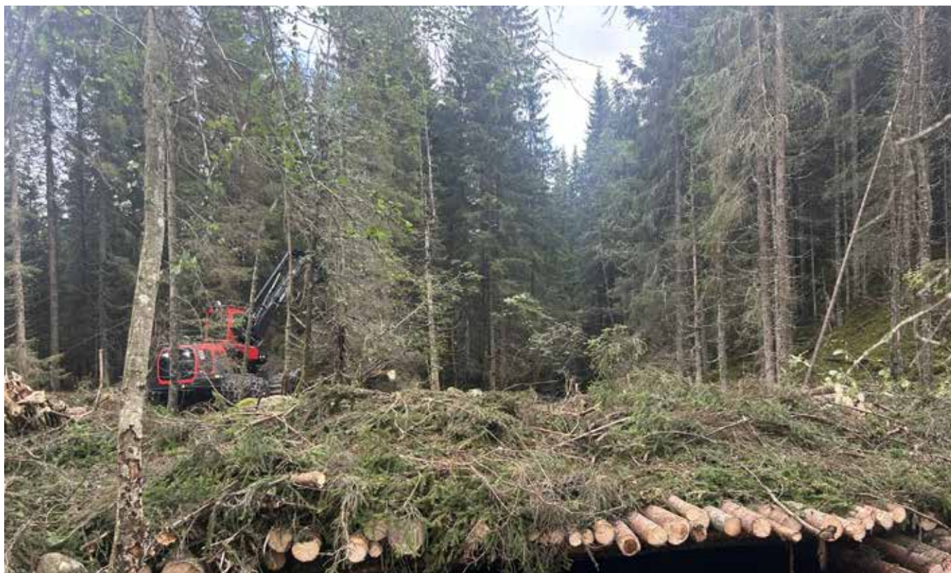
Bygging av midlertidig bru over Fura for tømmertransport. Foto: Håvard Dufseth.
